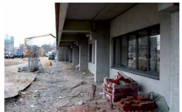
Vor den Fanräumen ist derzeit noch eine Baustelle
